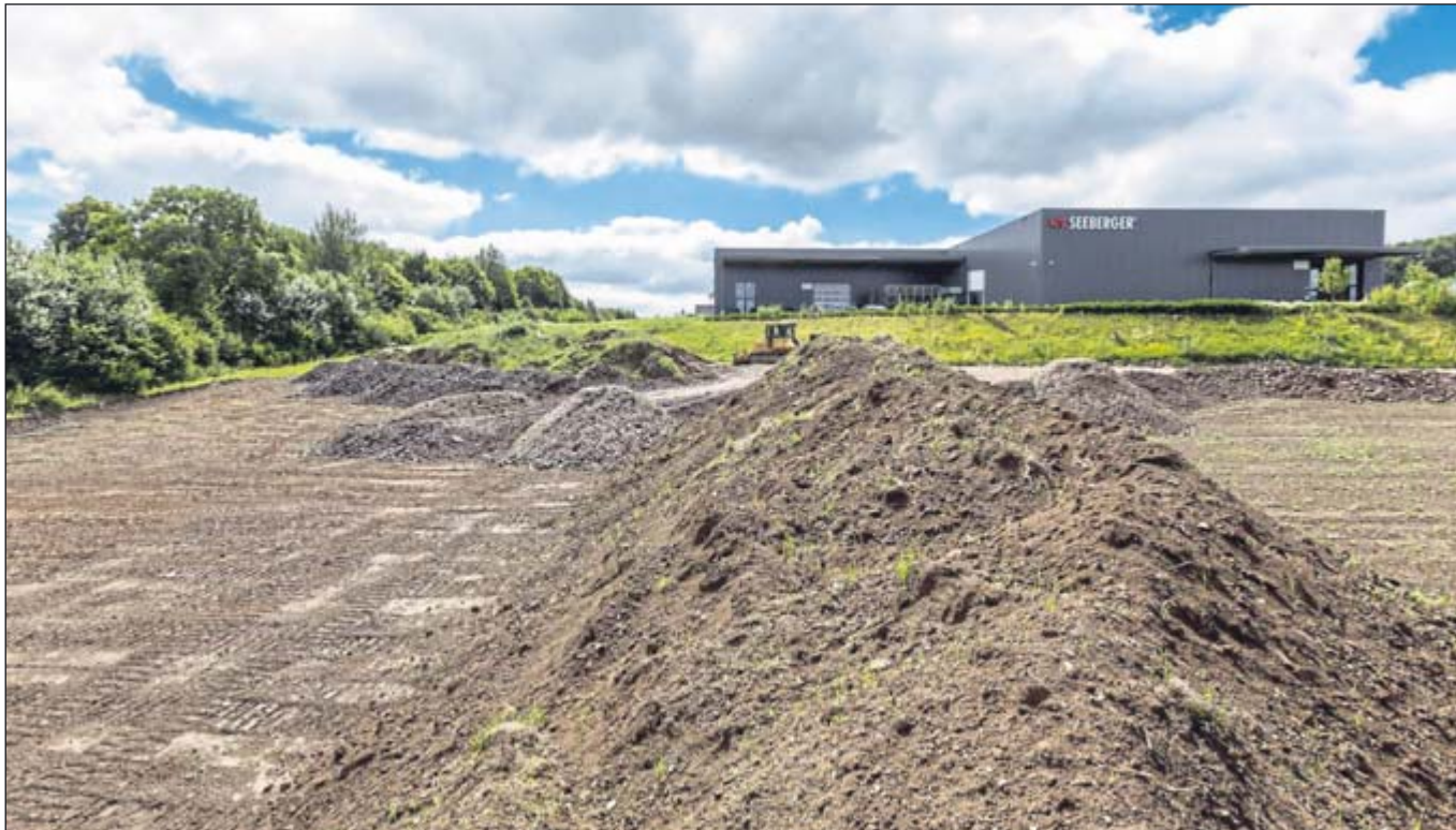
Der Rohrspezialist Seeberger erweitert sich an seinem Unternehmensstandort im Gewerbegebiet Heedfeld-Süd. Die Erdarbeiten für einen Hallenanbau laufen bereits. ■ Foto: Bahr
