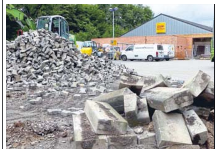
Das Pflaster auf dem Wansbeckplatz wird komplett aufgenommen, die Arbeiten begannen am Montag.
